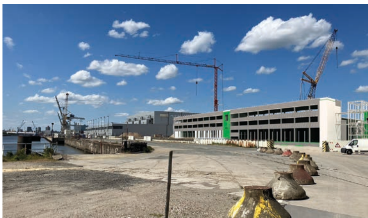
Abbildung 1: Rohbaumodell als Vorschau im Baustellenfoto
