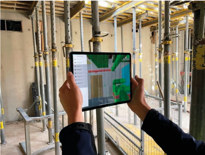
Abbildung 3: AR auf der ZfS-Baustelle
