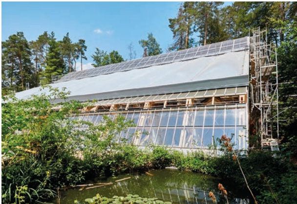
Abbildung 2: Tatsächliches Gebäude im Bau
