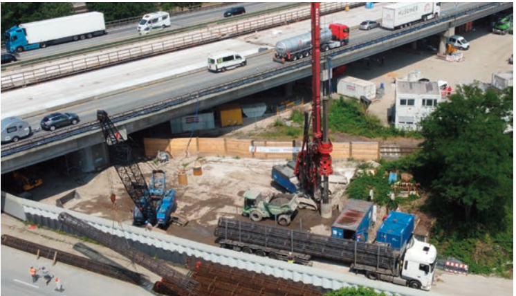
Abbildung 2: Bohrfahlarbeiten – Bauausführung
