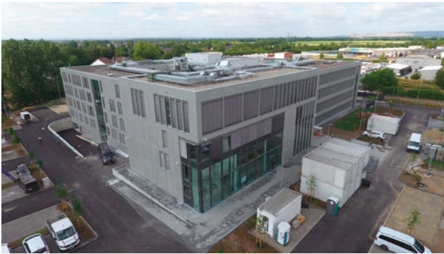
Abbildung 1: Die Kreispolizeibehörde Baustellen Luftbild Rhein-Erft-Kreis in Bergheim (Stand Juni 2023)
